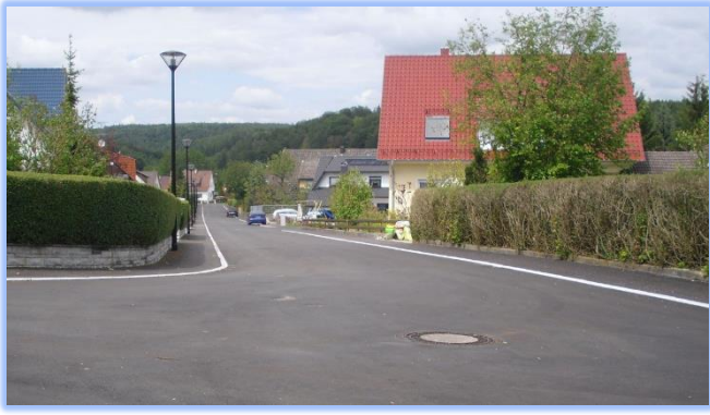
Die Kreuzeckstraße nach der kompletten Sanierung.
