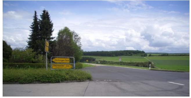
Die Kreuzung Kleinkuchen/Elchingen/Neresheim erhielt einen neuen Fahrbahnbelag.
