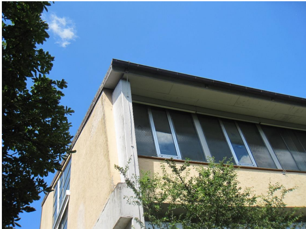
Bild 16: In den Abrissgebäuden gibt es zahlreiche Spalten und Nischen. 2021 konnte nur die Kohlmeise als Gebäudebrüter festgestellt werden. Aufgrund von herausragenden Strohresten ist es sehr wahrscheinlich, dass in früheren Jahren weitere Neststandorte an den Gebäuden vorhanden waren. A. RAICHLE, 17.06.2021
